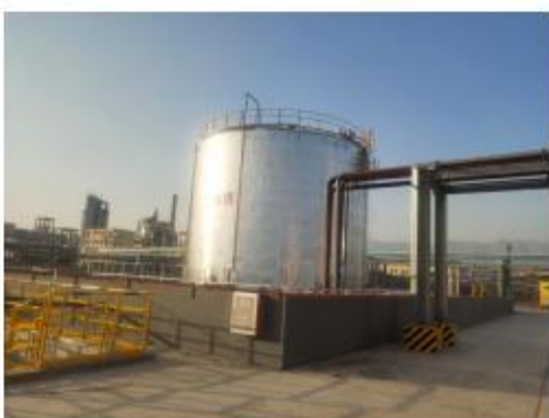
焦油罐区围堰
