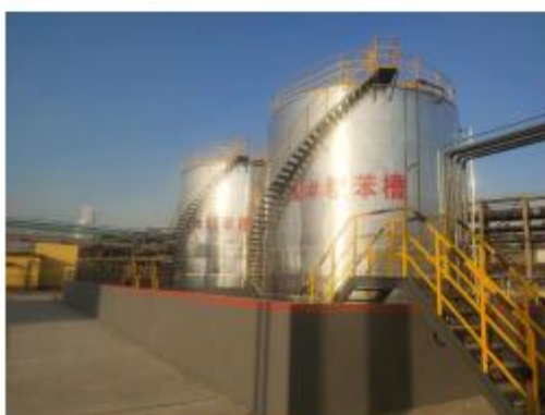
粗苯罐区围堰
