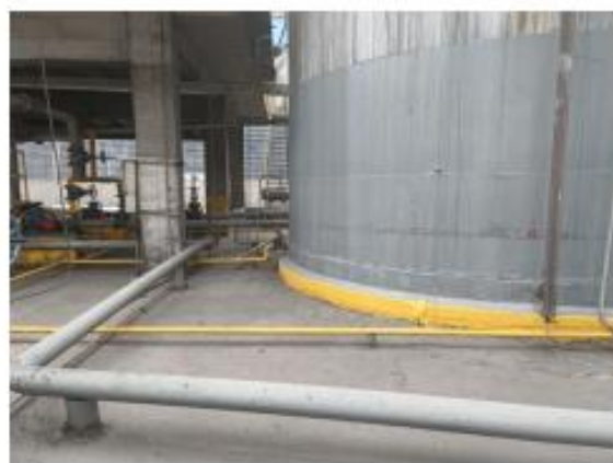
循环氨水槽事故管网
